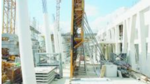
Le chantier de la médiathèque à Grammont est déjà très avancé
